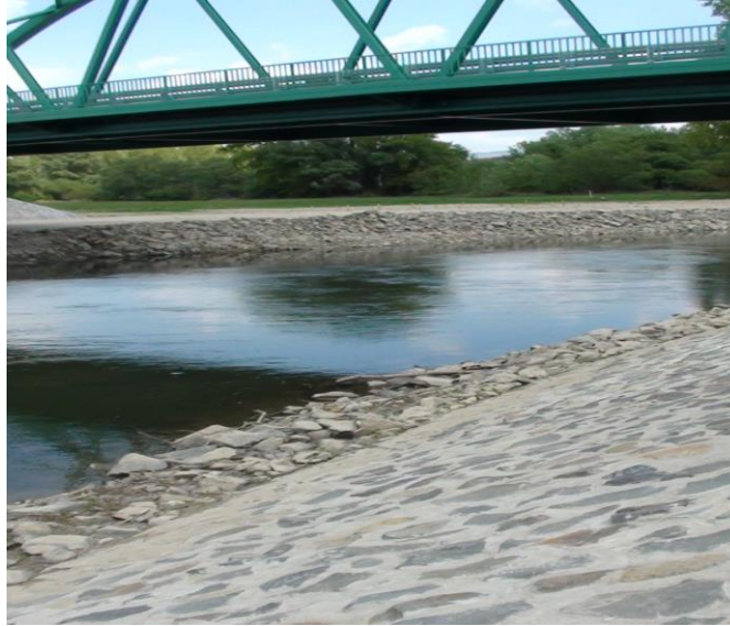
2. sz. kép: partbiztosítások a híd környezetében (a felső részen a szlovák oldali partbiztosítás)
